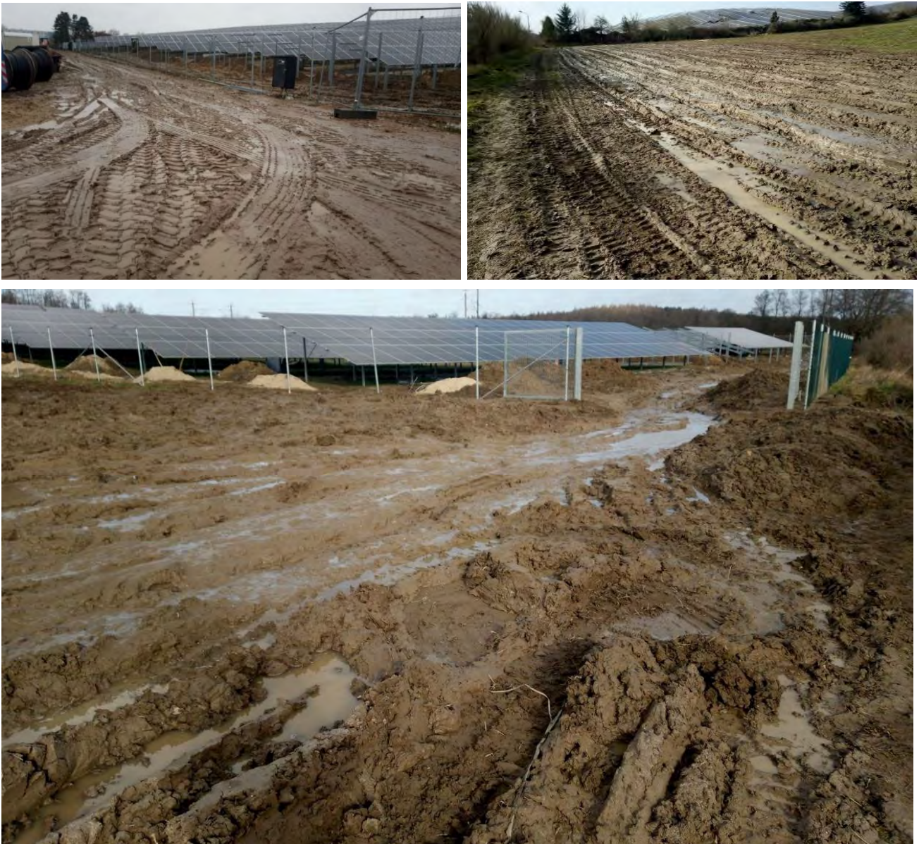
Foto 1-3: Befahrung ungeschützten Oberbodens bei ungeeigneter Witterung/Bodenfeuchte führt zu Schädigung des Bodengefüges und schränkt die Funktionsfähigkeit des Bodens ein
